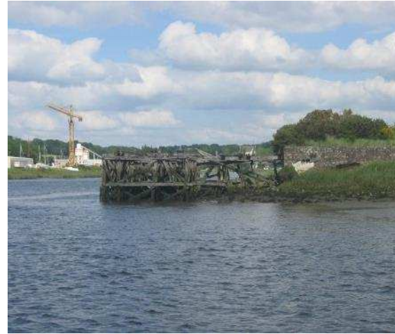
FIGURE 15 - QUAÏ ET ESTACADE SUR PIEUX EN 2006 (SOURCE : LORIENT AGGLOMERATION - INGEROP)
