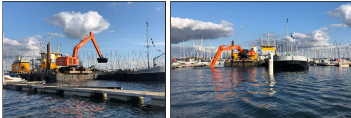
FIGURE 52 - DRAGAGE MECANIQUE PAR PELLE (SOURCE : MERCERON TP, 2020)
