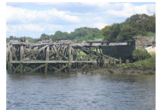
Photographie du quai et de l'estacade (non daté, a priori 2006-2007)
