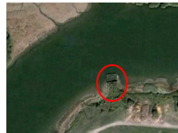
Quai et estacade en bois, vue satellite (2005)
