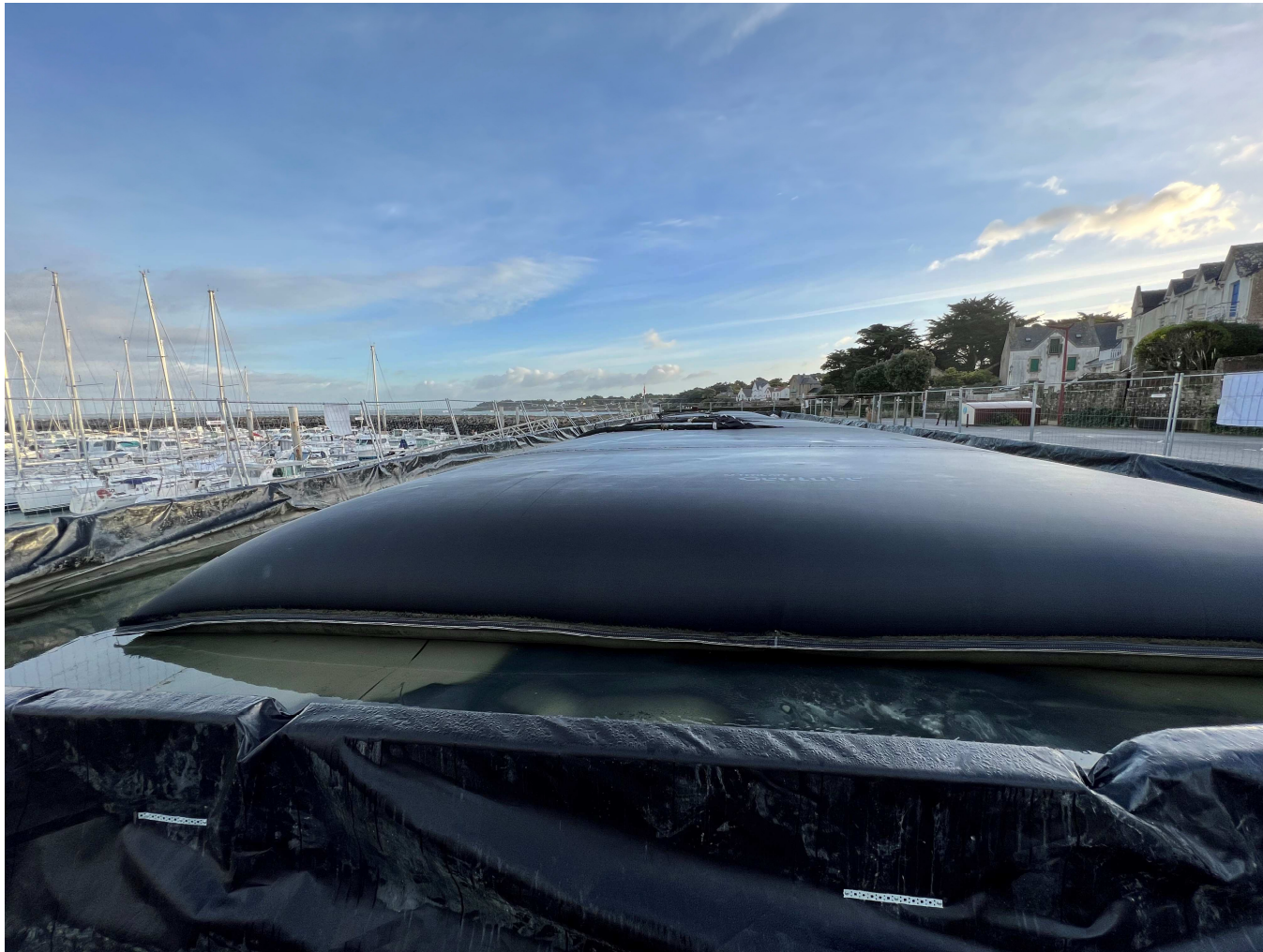
FIGURE 11 - PHOTOGRAPHIE D'UN GEOTUBE - SOURCE : ENVIROMER
