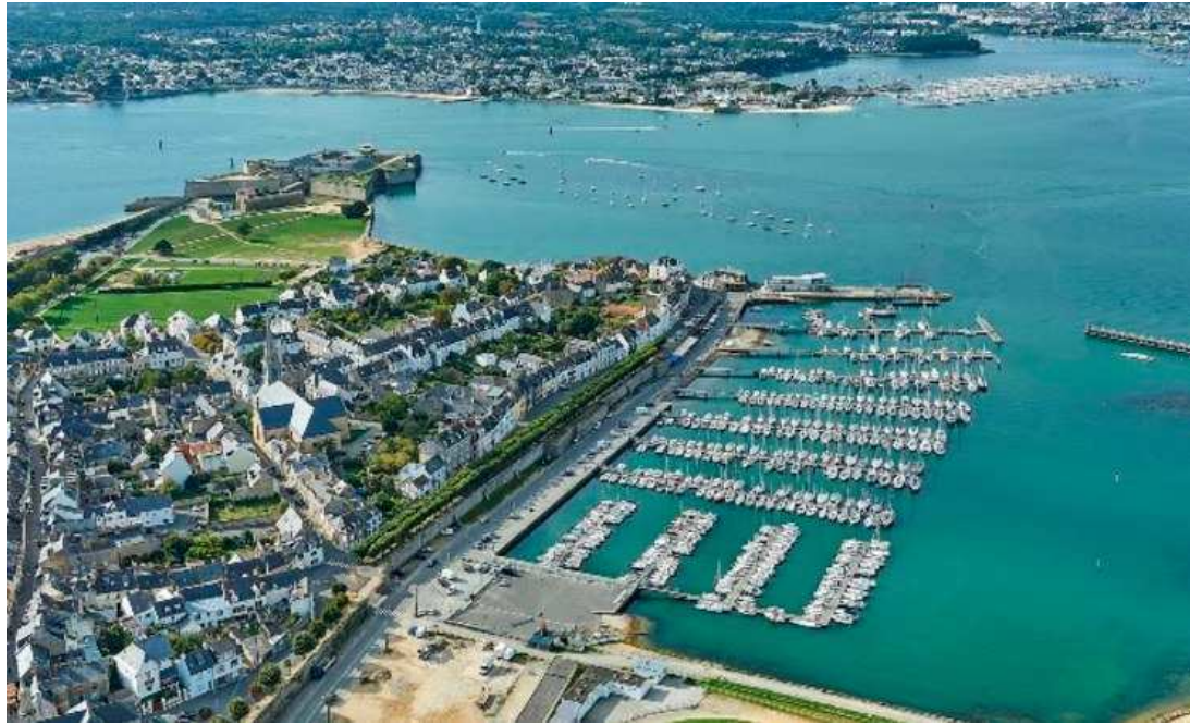
FIGURE 35 - VUE AERIENNE DU PORT DE PORT-LOUIS (SOURCE : LORIENT BRETAGNE SUD TOURISME – INGEROP)
