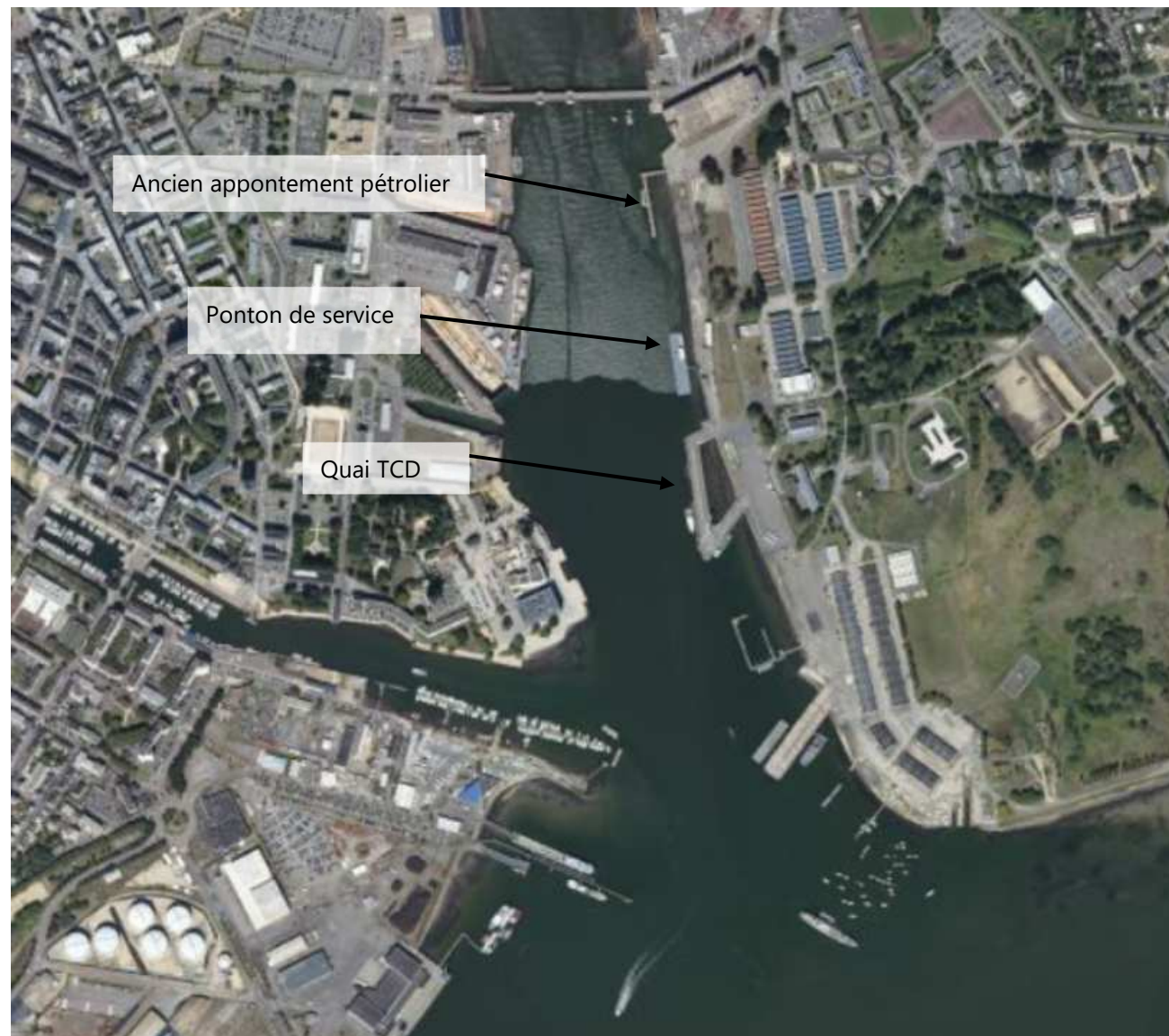
FIGURE 43 – VUE DE LA ZONE DE SCORFF AVAL (SOURCE : GEOPORTAIL)
