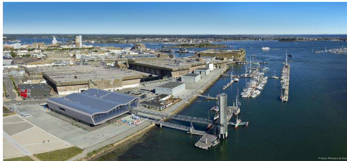
FIGURE 29 - PORT DE LORIENT LA BASE (SOURCE : PATRIMOINE.LORIENT.BZH - INGEROP)
